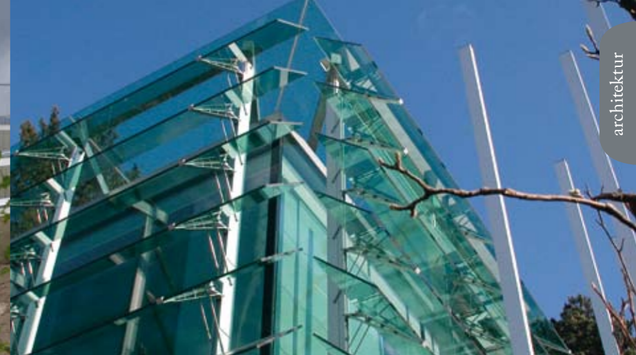
Akademie der Wissenschaften, Rennweg – die interaktive Glasfassade reagiert auf Sonneneinstrahlung
